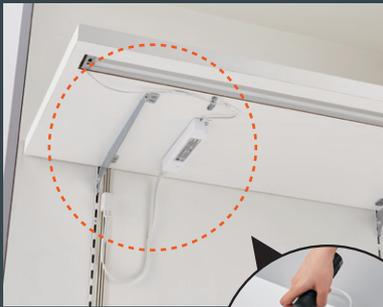
スリムアダプタは直流電源装置なのでPSEの対象。ビス固定すると棚板は「電気機械器具付家具」扱いとなり、**PSEの対象**となります。
