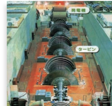
火力発電も原子力発電も水を沸かして蒸気を作り、その力でタービンを回して発電機で発電します。水力発電で回す水車もタービンと同じ動きをします。
